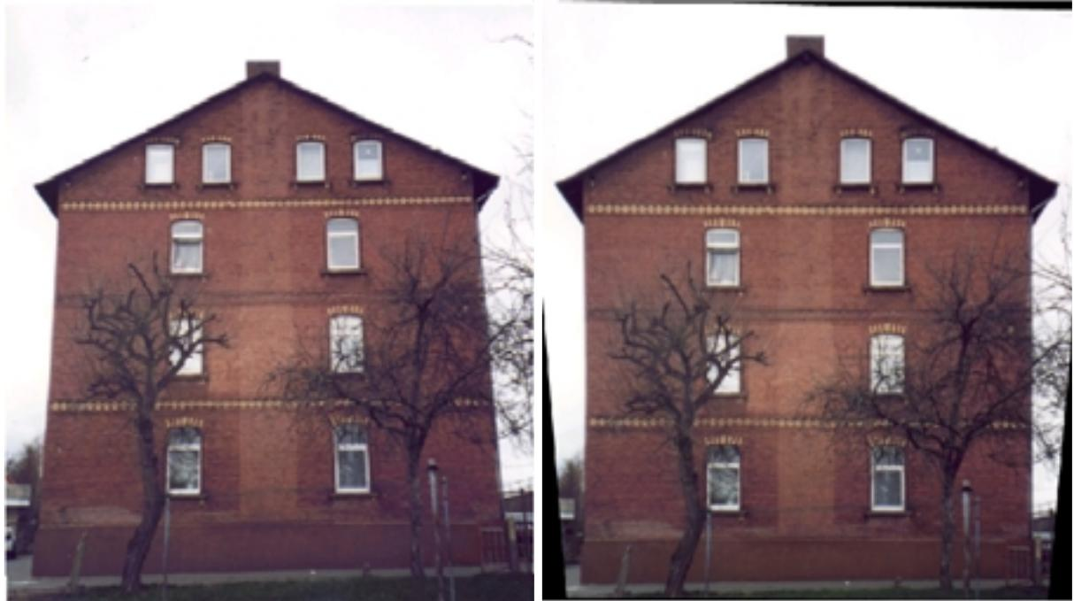
**Bild 12:** Photographie original (links) und entzerrt (rechts). Das Objekt ist ein Mehrfamiliengebäude mit sehr einfacher Fassade.
